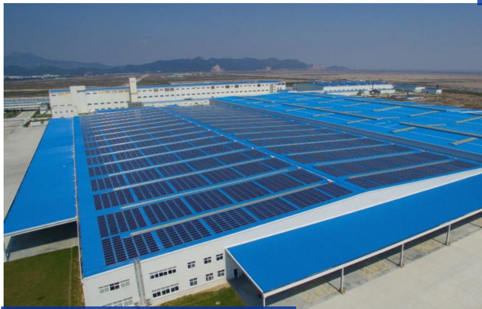
台州吉利陆虎生产基地 6.8MW屋顶光伏电站
